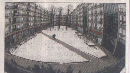
Der Innenhof des Pallasseums. Noch vor zehn Jahren war der Baukomplex stadtwweit als „Sozialpalast“ verrufen
